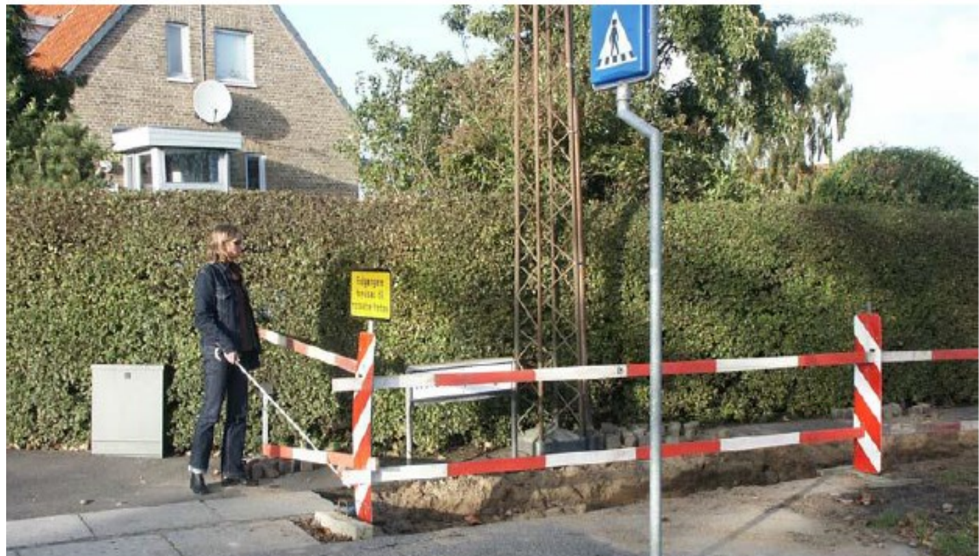
I den daglige drift skal tilgængelighed også tænkes ind ved eksempelvis gravearbejde. På billedet er afmærkningen opstillet for tæt på udgravningen. Billedet er fra Håndbogen Tilgængelighed for alle
