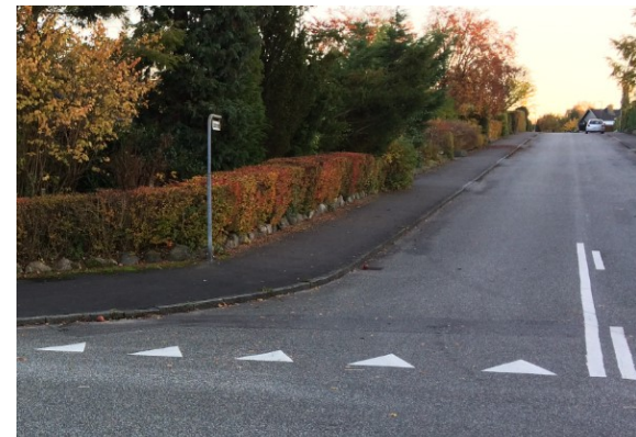
Asfaltfortov med kantsten i granit - Blovstrød
