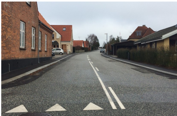
Nyvangsvej - Fortove i asfalt og in-situstøbte kantsten
