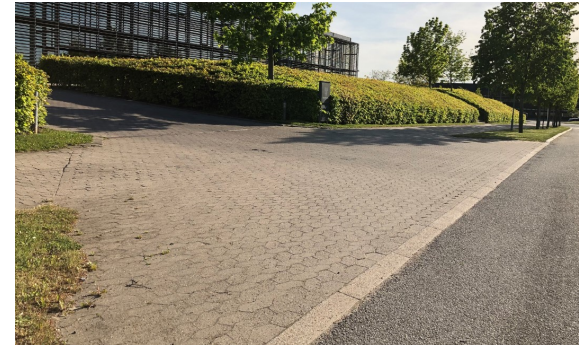
Bjarkesvej - Overkørsel, fortov og cykelsti i SF-sten.
