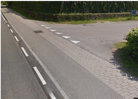
Kollerødvej/Gravenstensvej - Overkørsel med gennemgående cykelsti/fortov med belægningssten. Rampe i asfalt, da kantstenen er ikke sænket.
