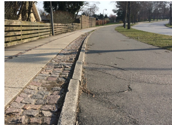
Sjælsø Alle, fortov med betonkantsten mod cykelsti
