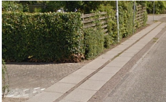
Boligvej - Overkørsel til ejendom med sænket kantsten og gennemgående fortov.
