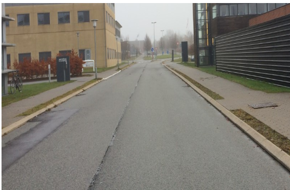
Rørmosevej - Fortove med SF-sten og betonkantsten
