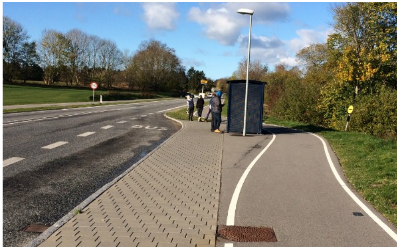
Sandholmgårdsvej - Betonsten på fortov ved busstoppested
