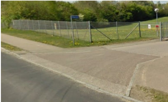
Vassingerødvej - Overkørsel i asfalt markeret med brosten i kanten.
