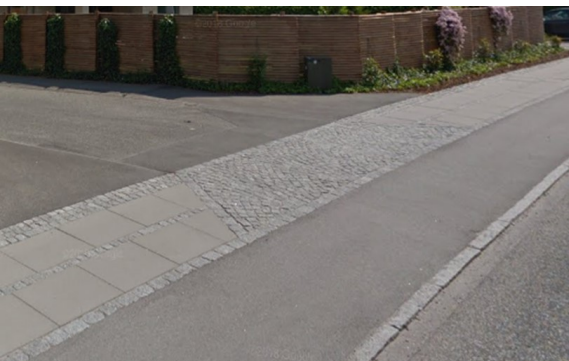
Frederiksborgvej - Overkørsel til Svinget med gennemgående cykelsti i asfalt og brosten på fortov.
