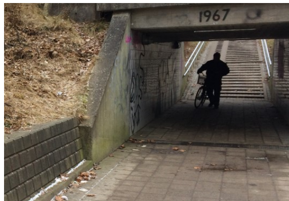
Sti under Banevang til Poppelvej med belægningssten
