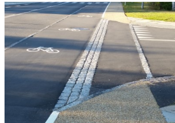
Banevang/Poppelvej - Overkørsel med gennemgående cykelsti. Overkørslen er udført i asfalt og brosten for markering af overkørslen.
