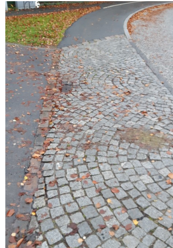
Overkørsel i chaussésten på Lyngevej ved Vibevej
